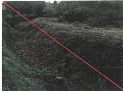
Ne pas laisser des résidus de renouée après le fauchage
