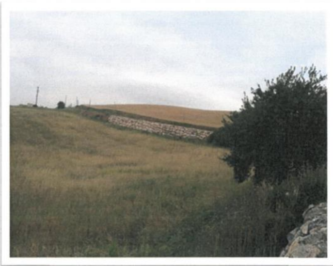
Les accotements de la voirie ont été renforcés en enrochement à divers endroits
