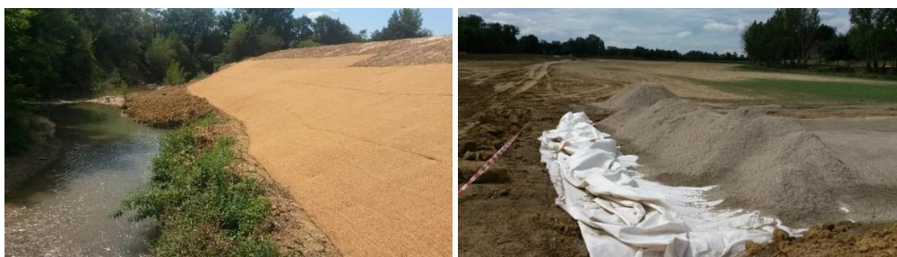
Les lacs de géotextile protègent la berge de l'arrachage en attendant les plantations et la croissance de la végétation (à g.) et un apport de sable renforce la plage (à d.)
