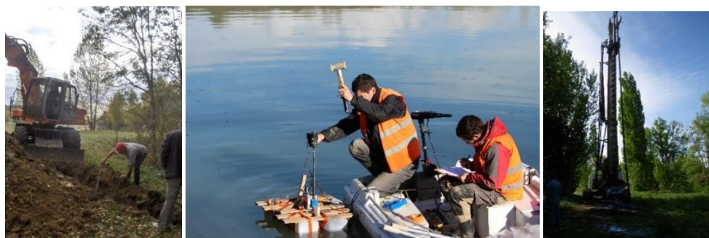
Études géotechniques (2007 et 2017) et injection des pieux béton (à d.)
