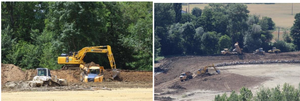
Les terrassements : 30 000 m 3 de matériaux mobilisés pour épaissir la digue
